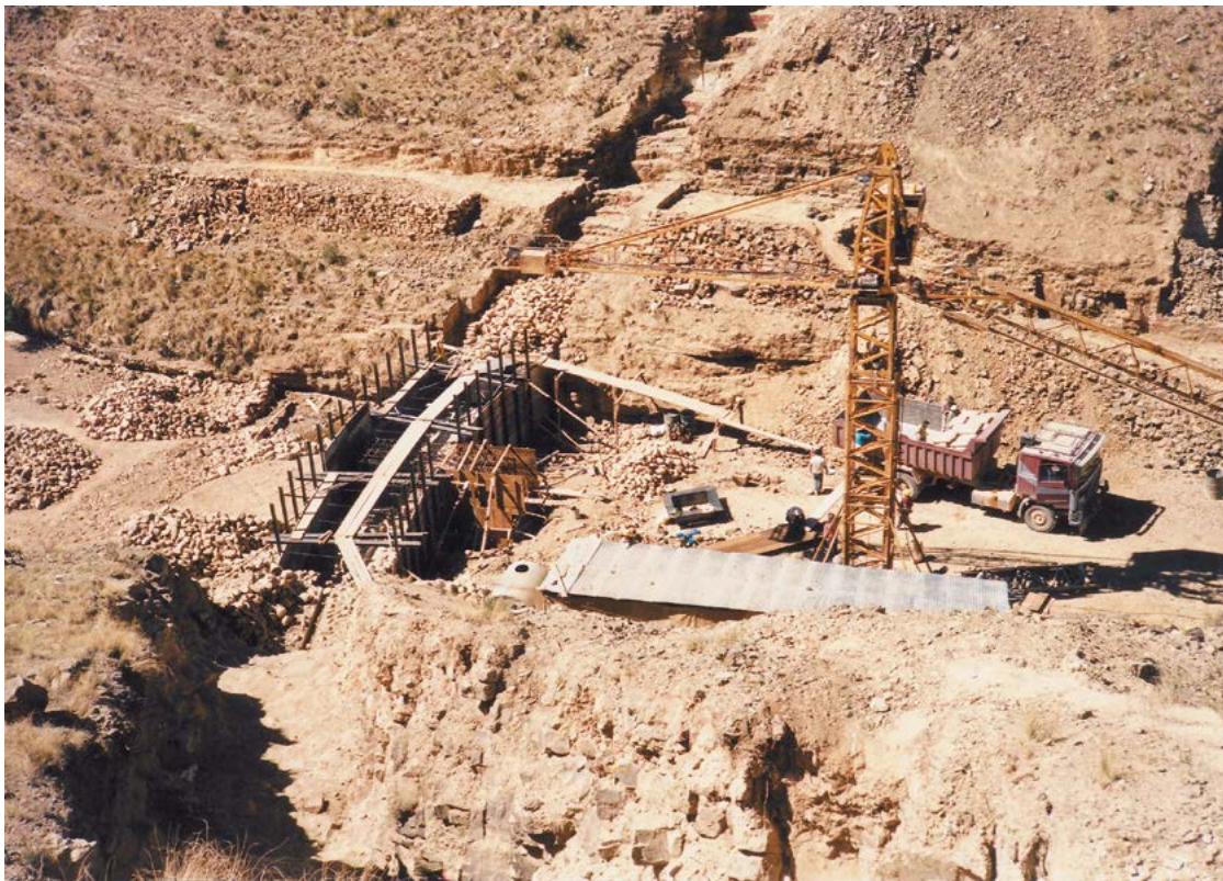
Construcción represa principal, 1998
