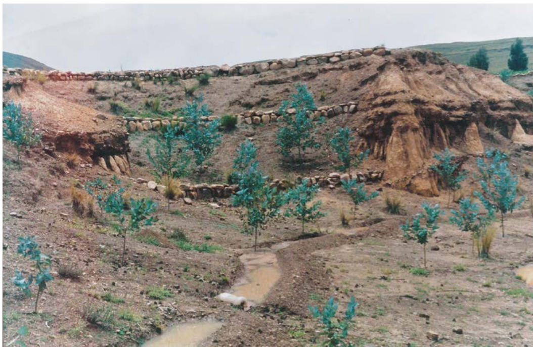
Obras de conservación de suelo y humedad a través de la construcción de zanjas de infiltración, 2001
