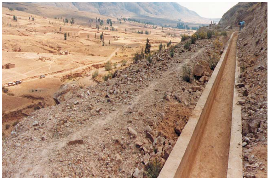
Sector norte. Arriba: construcción canal sector norte, 1998.
