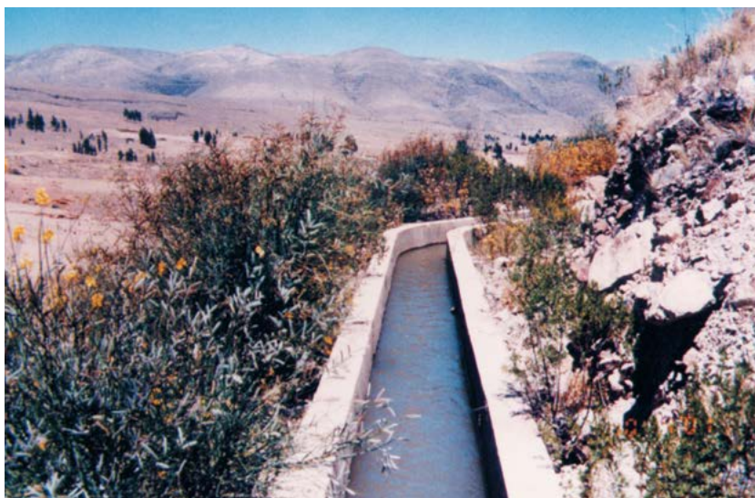
Canal norte en funcionamiento, 2011.
