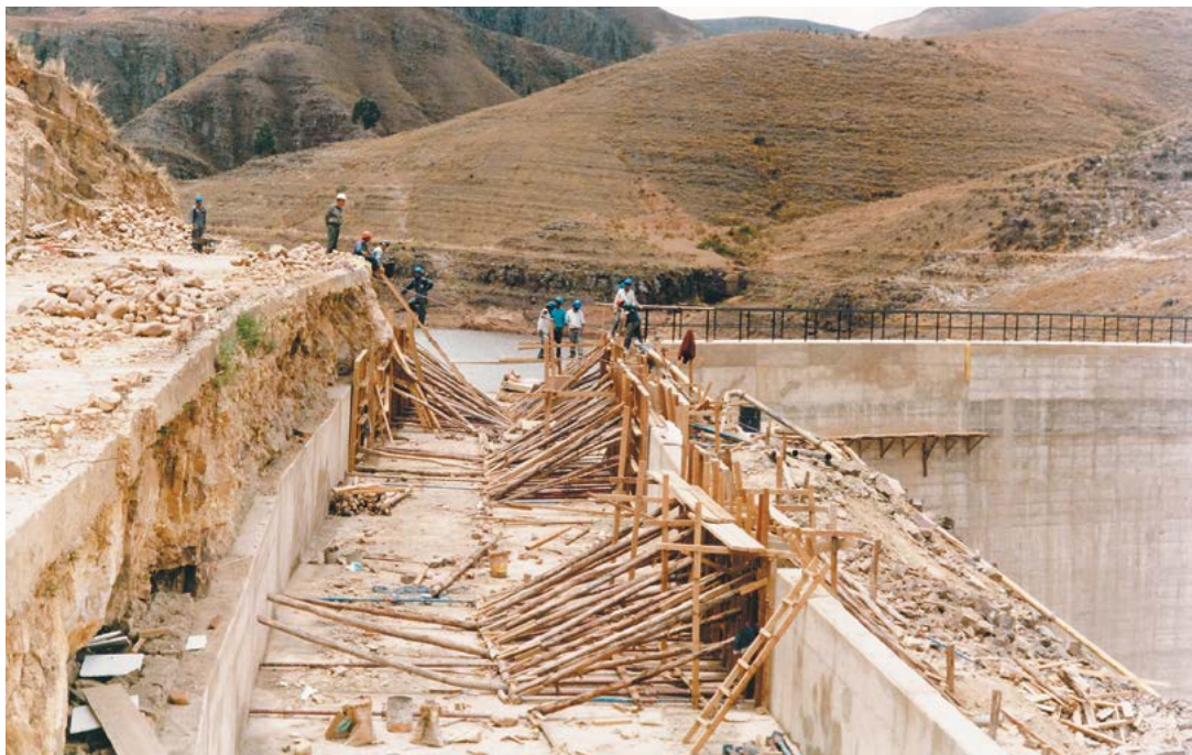
Conclusión de la Construcción de la represa principal, 2003.
