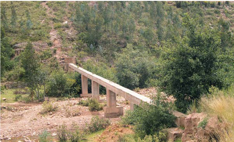
Sifón principal, que conecta al canal sur, 2009.
