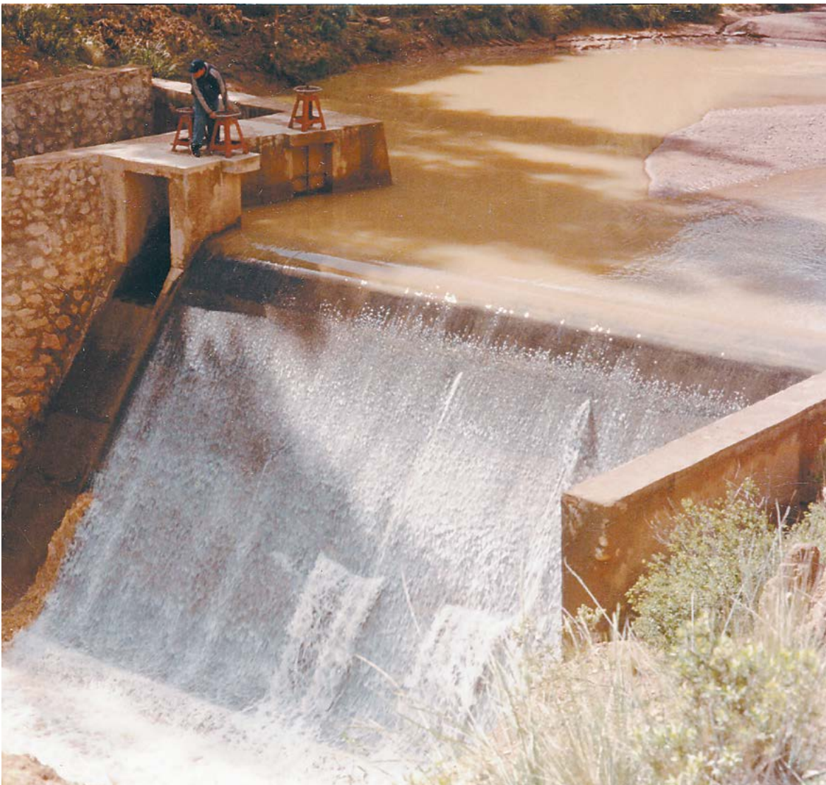
Compuertas de la represa derivadora, 2011.
