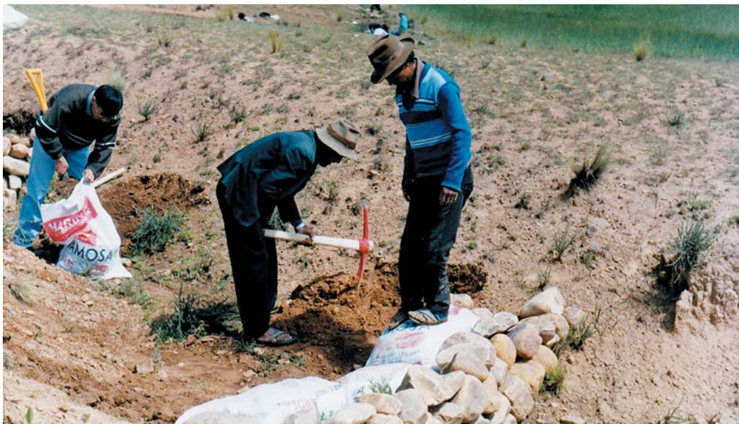
Inicio de la protección y conservación de suelos a través del control de cárcavas por terraceo, 1999
