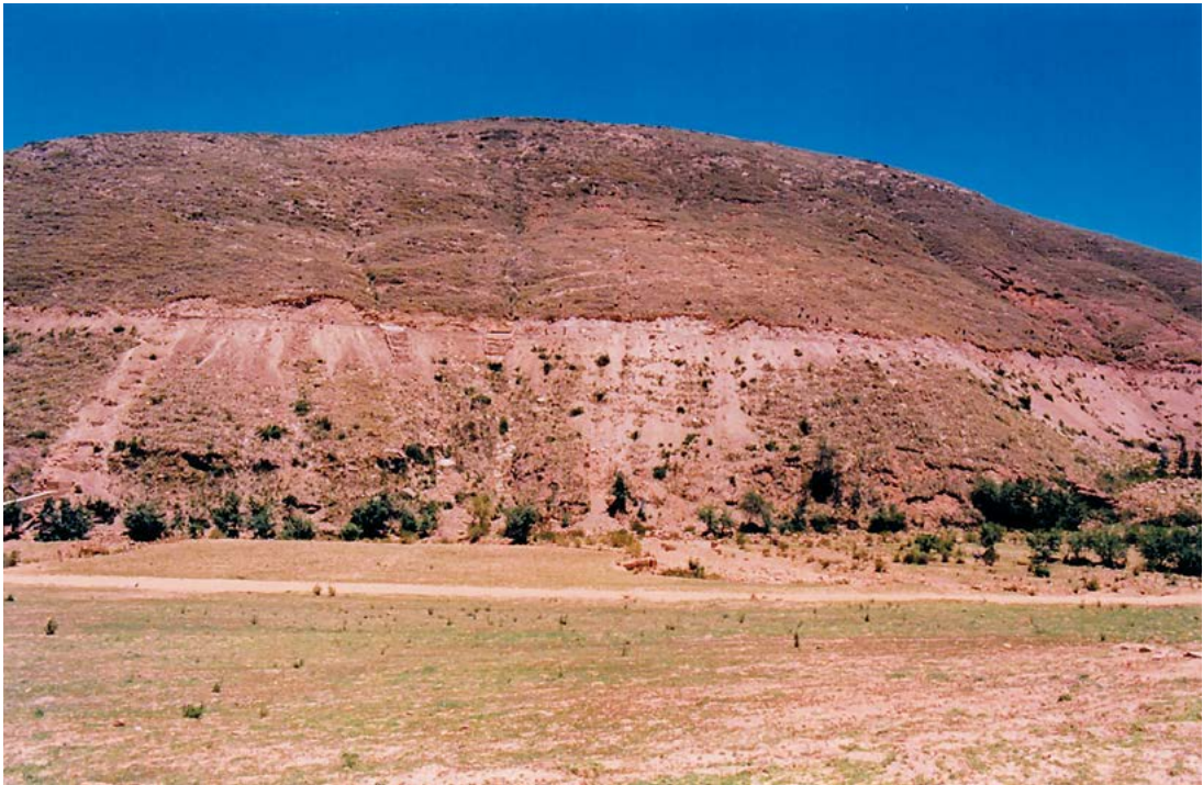
Sector del canal principal después de la construcción. Zona priorizada para la reforestación, 1999.
