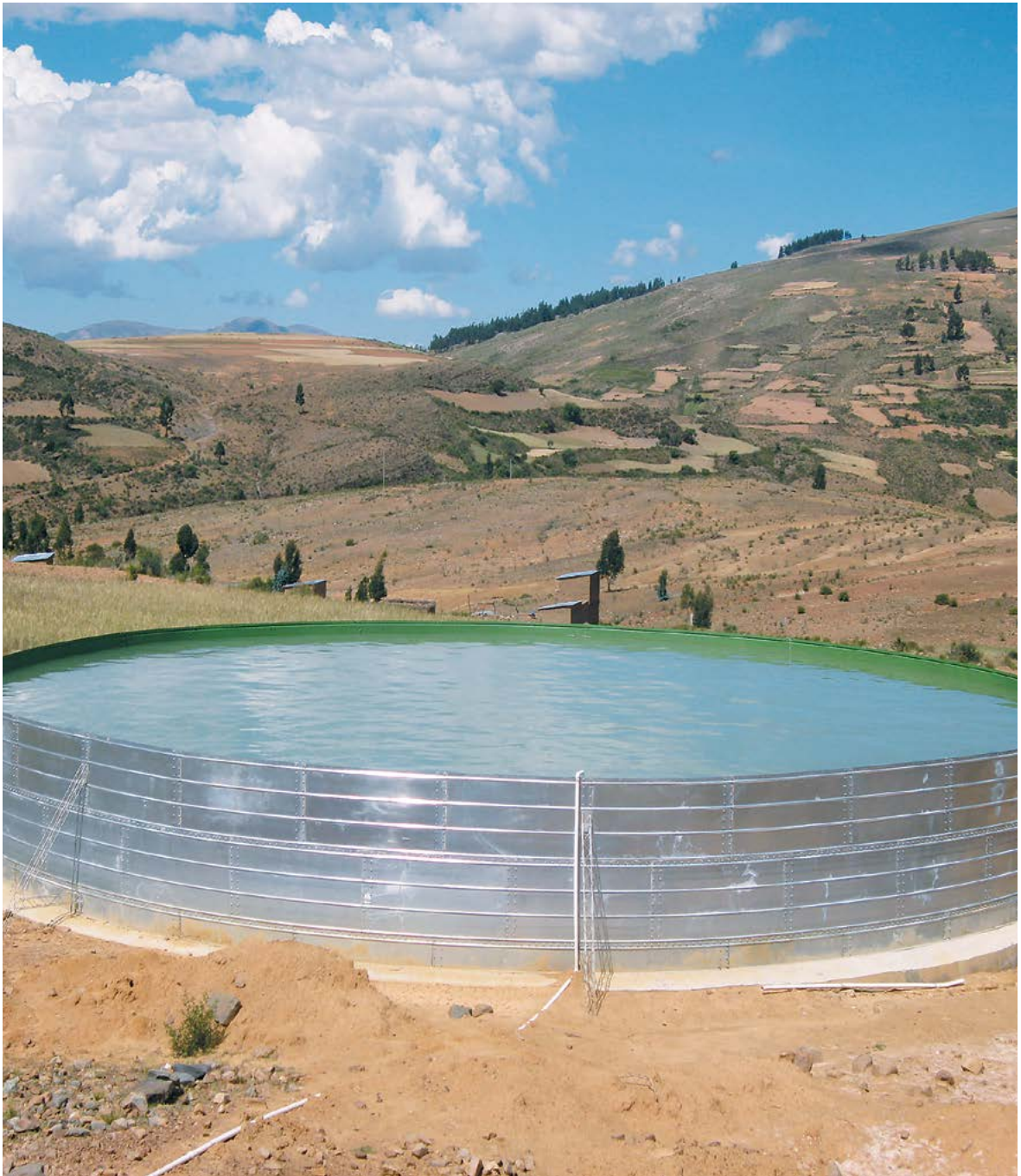
Atajado metálico para la cosecha de agua de vertientes en Anzaldo 2010
