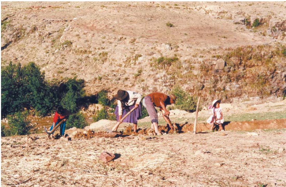
Construcción de canales de drenaje, 1999.
