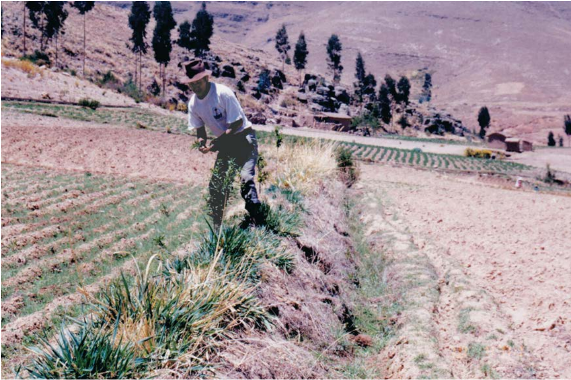
Estabilización de obras de conservación de suelos con la plantación de pasto phalaris, 2002.
