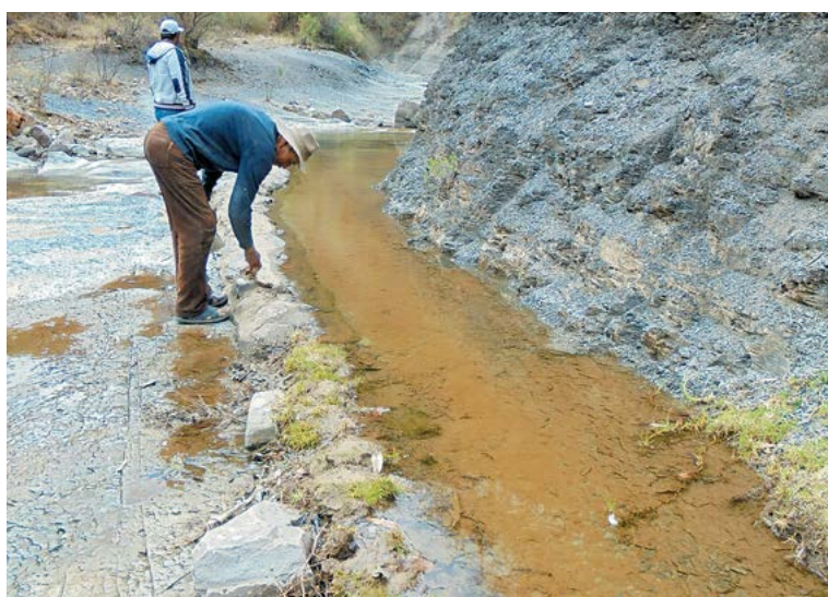
Obra de Toma – Comunidad Alfa Mayu – Anzaldo, 2013.
