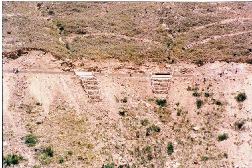
Construcción de muros de contención del canal principal, 1998.
