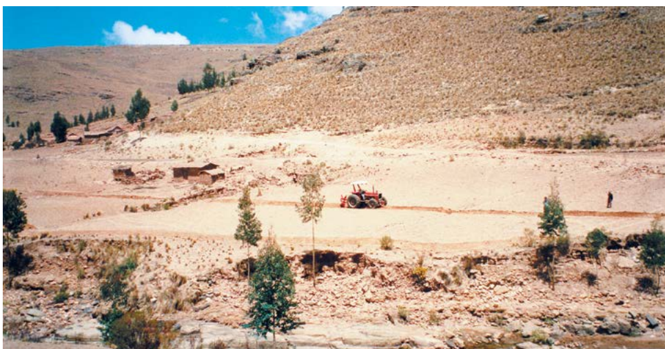
Construcción de terrazas con tractor, 2000
