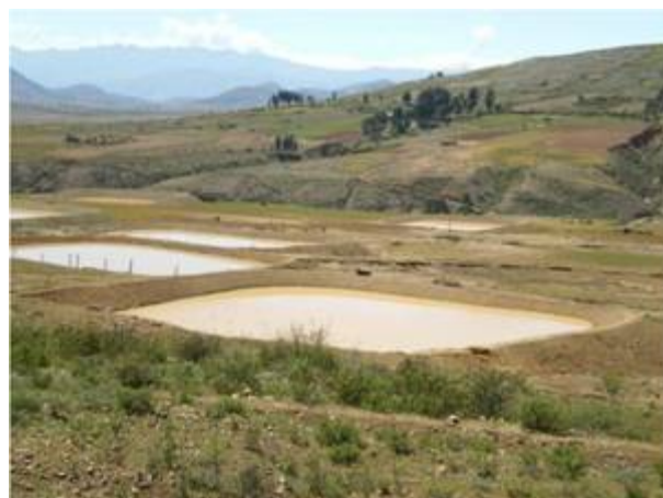
Cosecha de agua por atajados de tierra en Anzaldo - Cochabamba. Foto: CIPCA Cochabamba.
